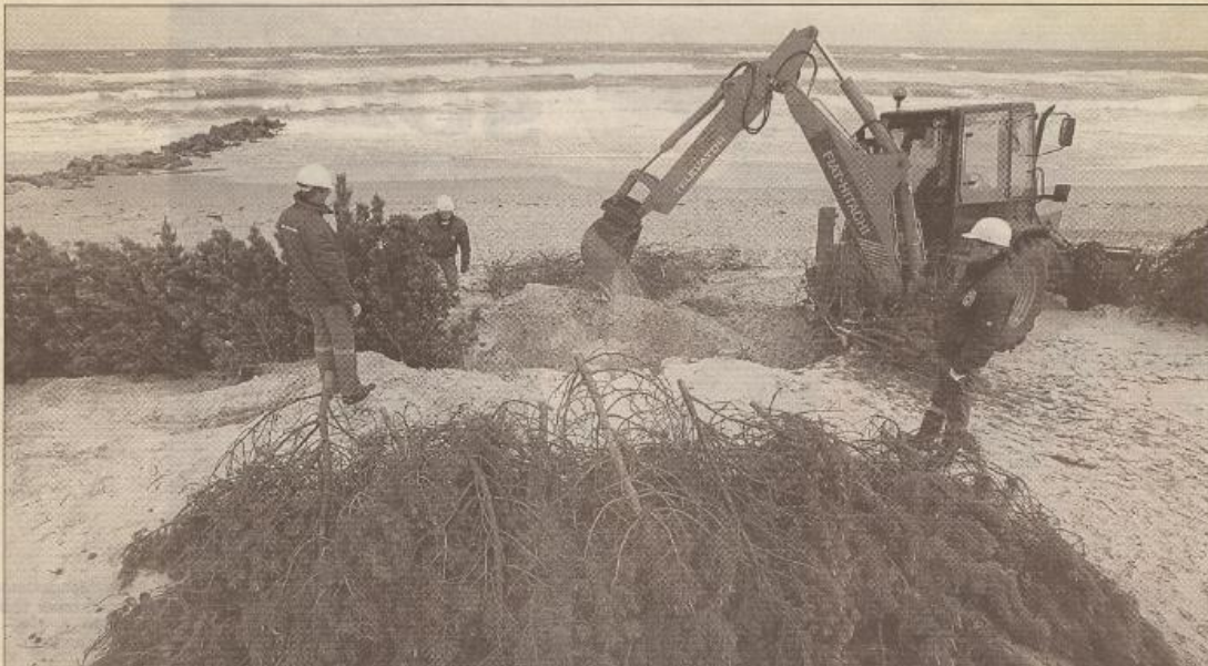
Grannis, som kommunens folk her er ved at sætte på plads ved Gl. Skagen, er med til at holde på sandet. Den bedste måde at sikres stranden er ved at fodre med sand, fremgår det af ny rapport. Foto: Peter Broen.
